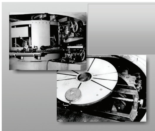
Рис. 2. Стенд-имитатор качки Scorsby фирмы Sperry, изготовлен в 1934 г., заводской № 2. Хранится в музее ЦНИИ «Электроприбор»
