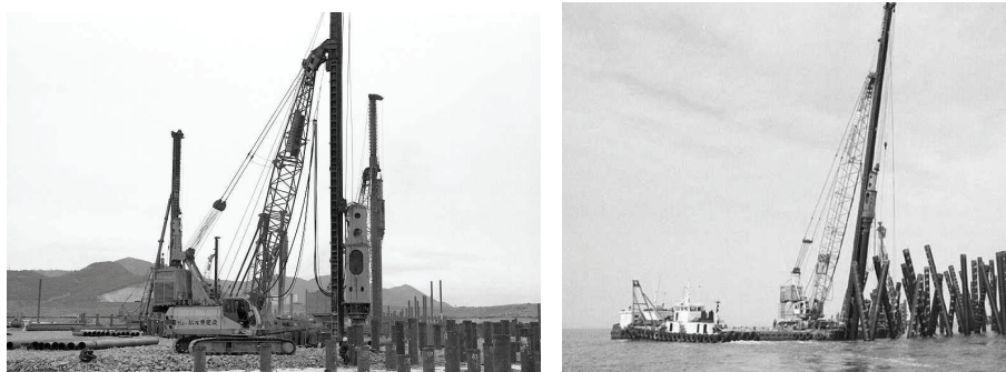
Рис. 1. Установка свай на суше и на море
