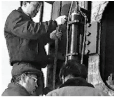
Рис. 8. Монтаж инерциального измерителя
